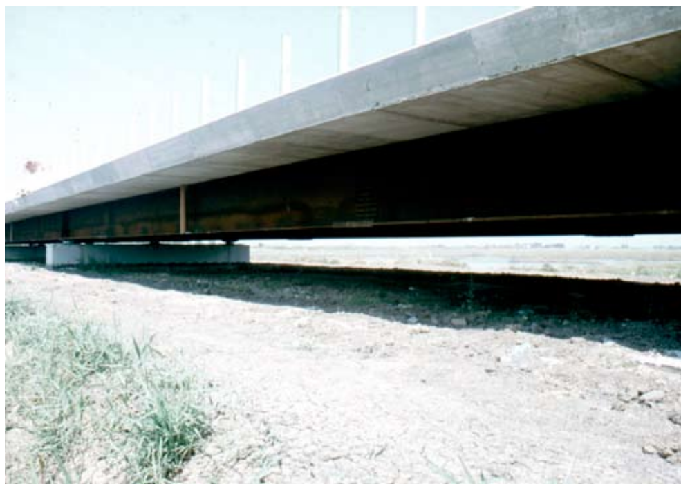
Fig. 32. Viadotto realizzato nel 2003 presso l'Oasi W.W.F. Orti-Bottagone (Piombino, Livorno) per ristabilire la connessione ecologica fra due ambienti palustri precedentemente separati da una strada ad alta densità di traffico.
