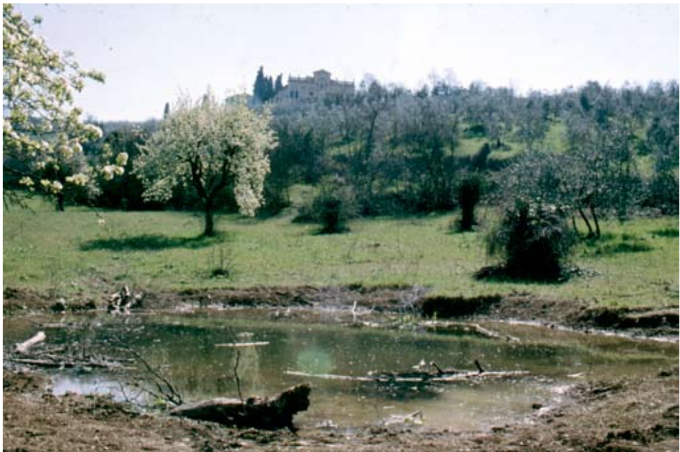
Fig. 31. Pozza alternativa alla conclusione dei lavori (Impruneta, Firenze).
