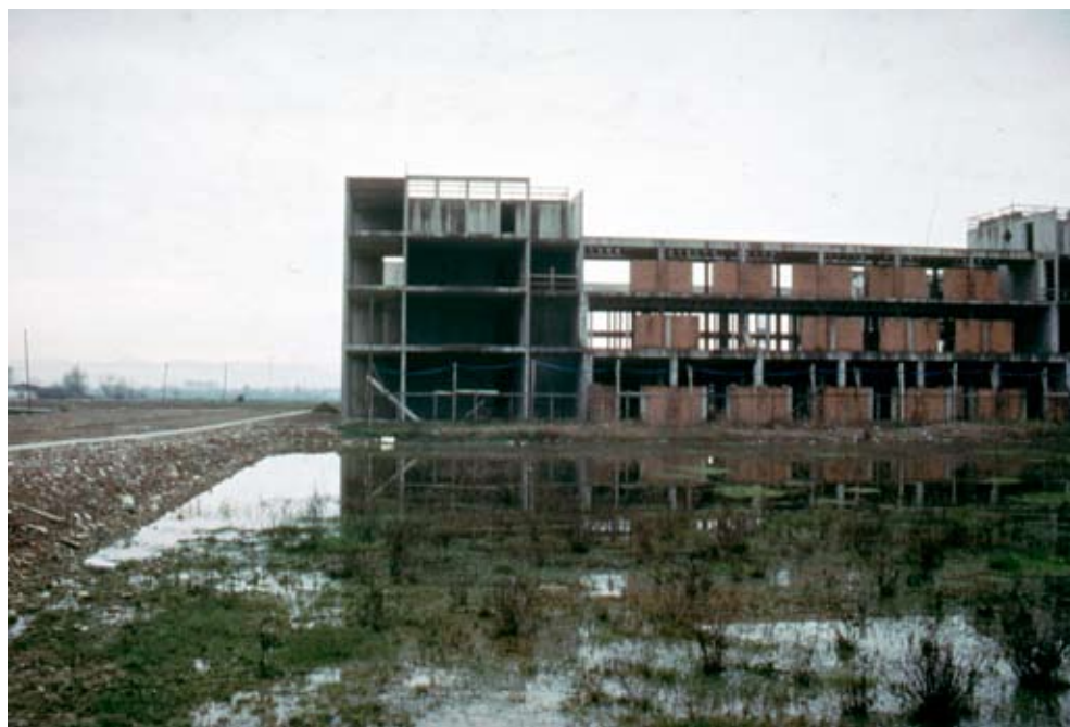
Fig. 27. Realizzazione di edifici in zona a vocazione palustre presso il Nuovo polo Scientifico Universitario di Sesto Fiorentino (Firenze, 1992).
