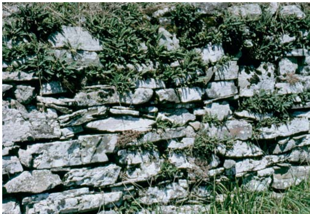
Fig. 23. Vecchio muro a secco.
