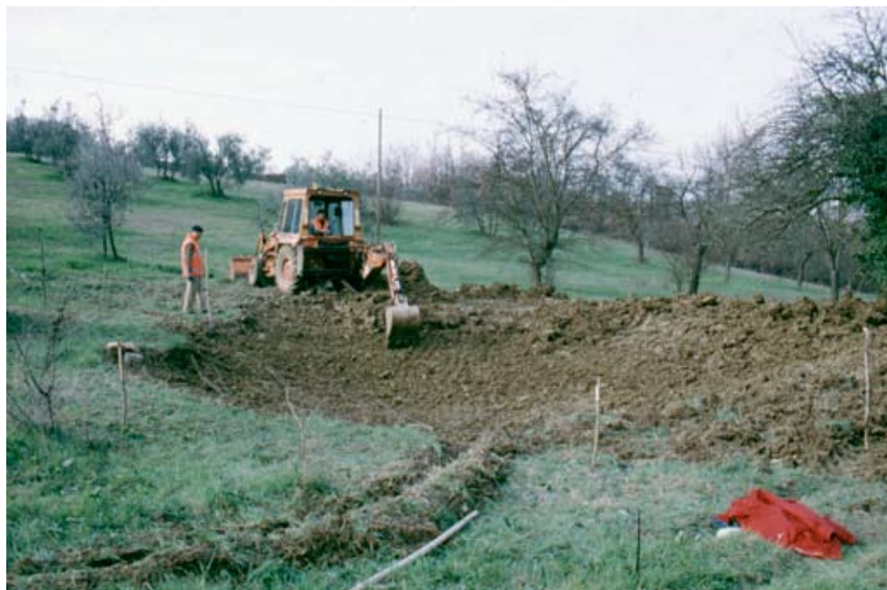
Fig. 30. Prime fasi di realizzazione di una pozza alternativa (Impruneta, Firenze).
