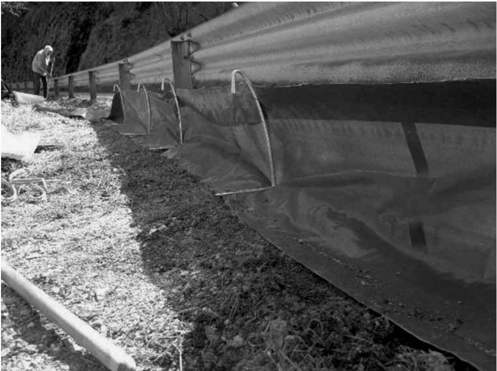
Fig. 1. La fase di posa in opera della barriera antiattraversamento usata per ridurre la mortalità da investimento stradale su di una popolazione di Salamandrina perspicillata nelle Marche.
