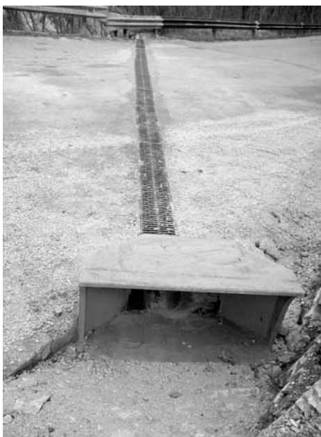
Fig. 2. Il tunnel sottostradale realizzato per favorire l'attraversamento in sicurezza della carreggiata da parte degli esemplari di Salamandrina perspicillata in migrazione nel sito riproduttivo di Monte Nerone (Marche).
