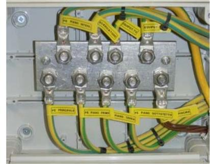
È di solito realizzato mediante una piastra metallica in acciaio zincato o in rame stagnato o cadmiato o una apposita morsettiera.
